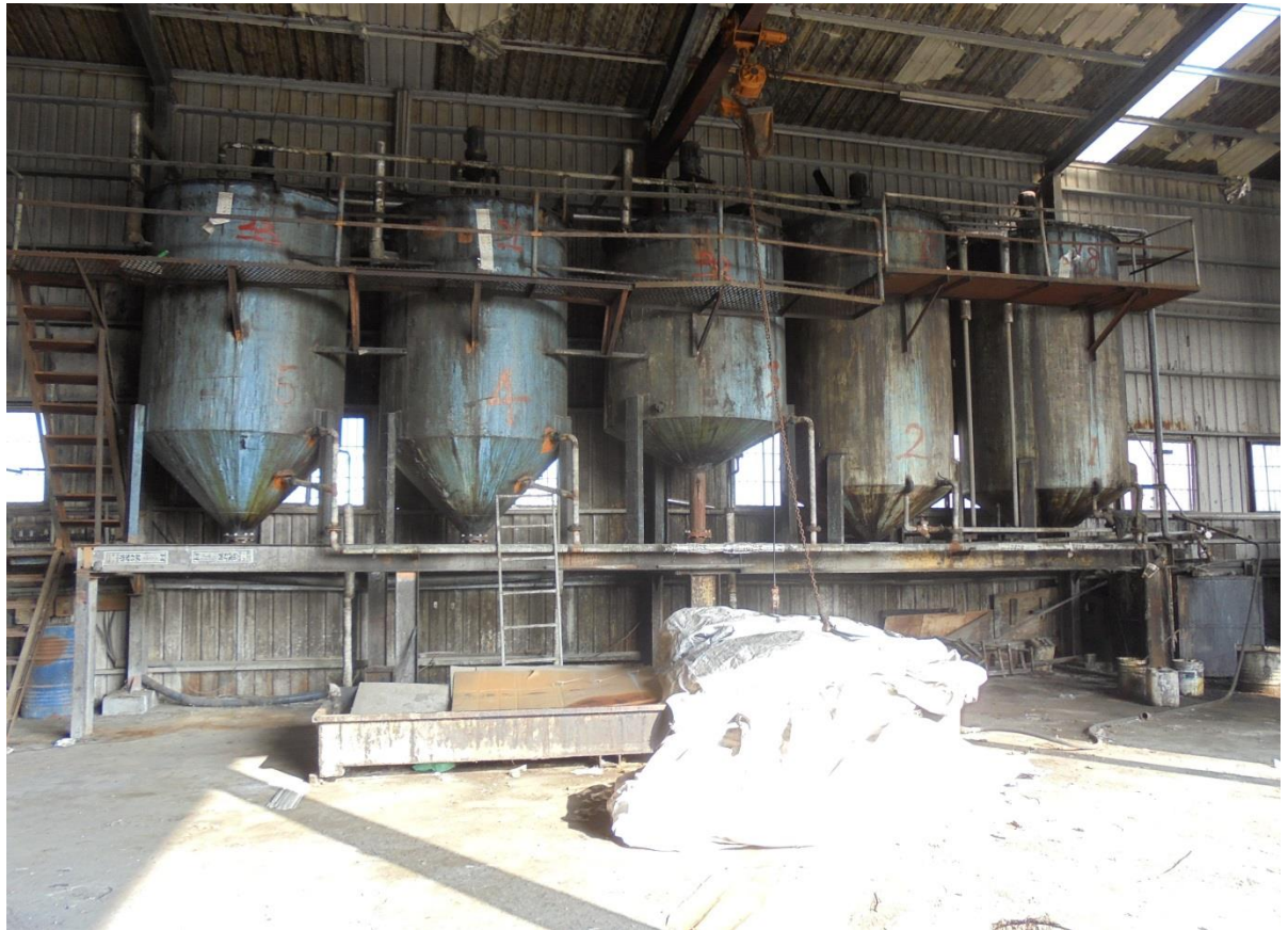
大型油槽(内含油品) 大型油槽(内含油品)
