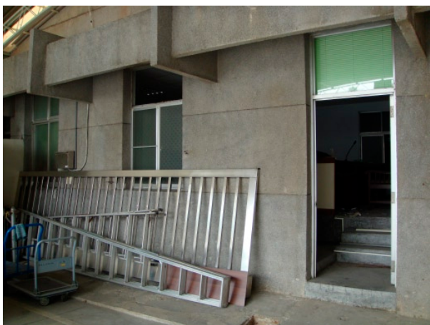
▲宿舍出入口整修前
