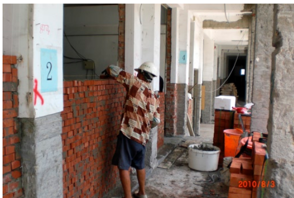
▲檔案庫房施工中
