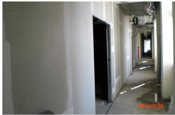
▲檔案庫房施工中
